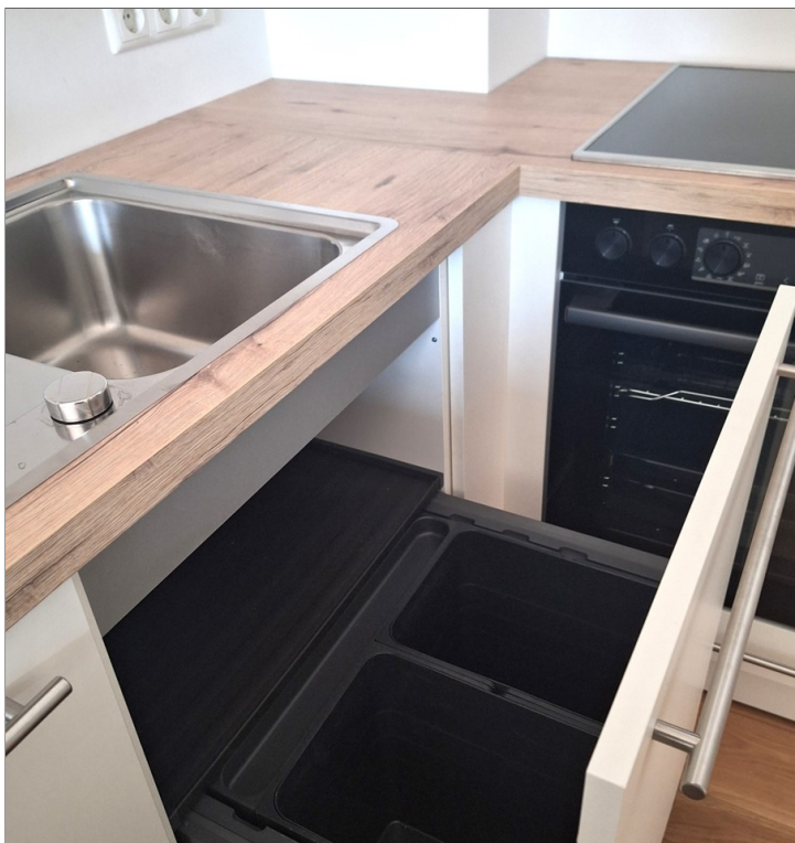
Spüle mit Abfall-Unterschrank
